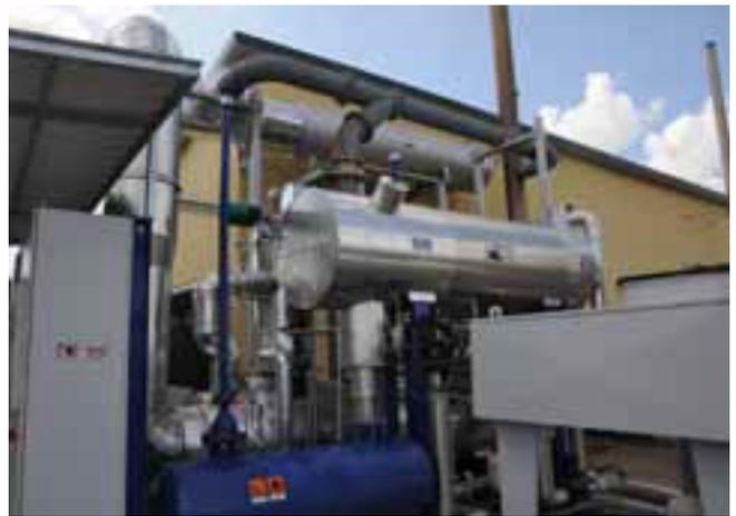
Dank der 2012 installierten ORC-Anlage werden für das größere BHKW mittels Zuführung ungenutzter Abwärme zusätzliche 8 Prozent Leistung bereitgestellt.
